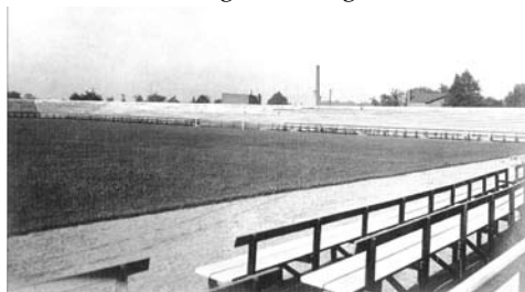
Die Adolf-Jäger-Kampfbahn 1921 nach dem Umbau der Ostkurve
